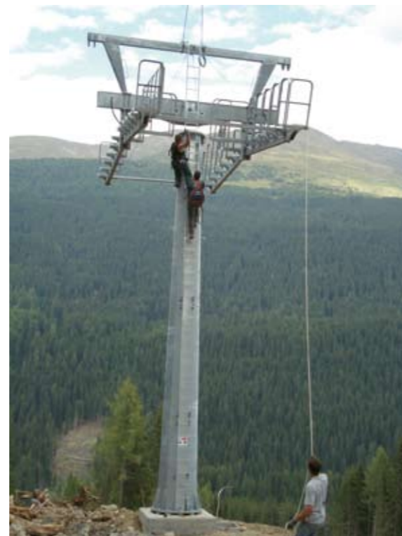
Bau der neuen Seilbahnanlage, Sommer 2007
